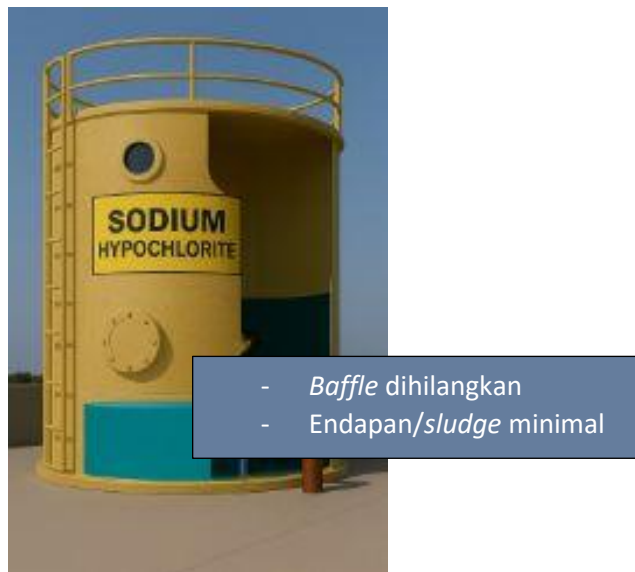
Gambar 30. Area Tangki Setelah Perbaikan
