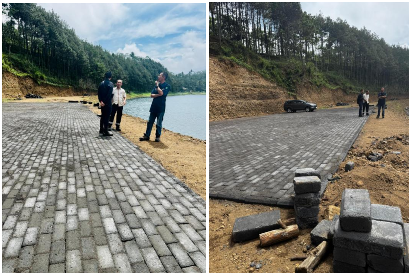
Gambar 36. Pemasangan Paving untuk Jalan
